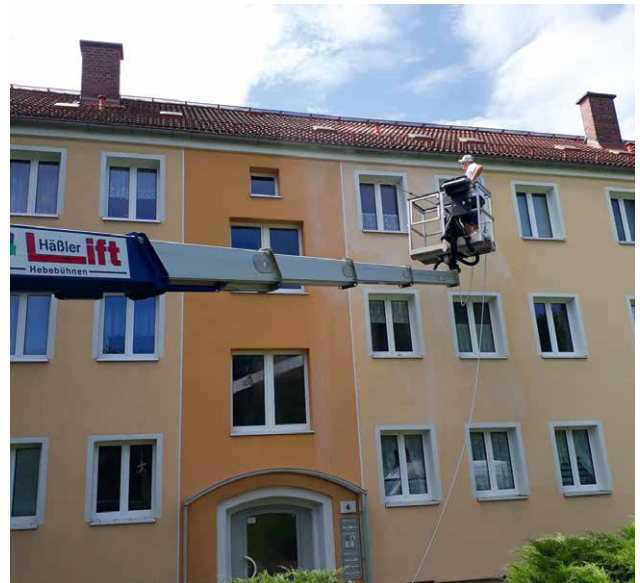
Während der Reinigungsarbeiten
