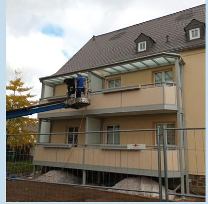
Reichenbrand – Balkonanbau mit Fassadeninstandsetzung
