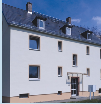
Rabenstein – Dach- und Fassadeninstandsetzung
