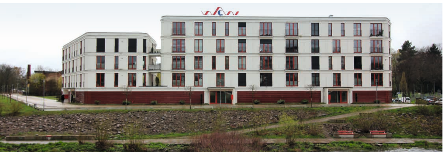
Von weitem gut sichtbar: Im Zentrum hat die WCW zum Ende des Jahres 2022 eine Werbeanlage auf dem Gebäude Aue 1 a – d errichten lassen
