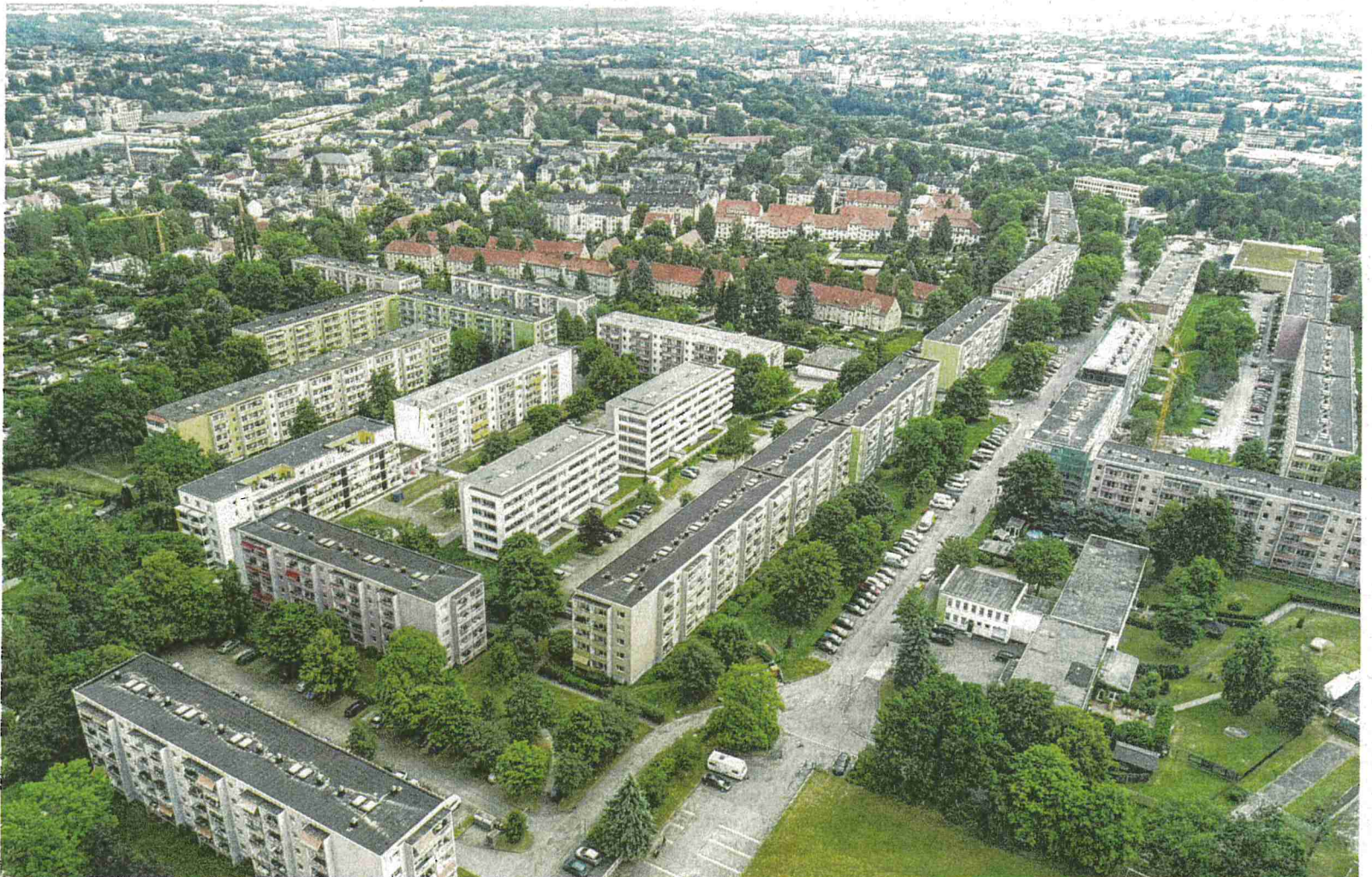
Eine kleine Stadt in der Stadt. Und es wandelt sich. Die langen Blöcke wurden zum Teil schon unterbrochen, um neue Blickachsen zu schaffen. Auch aktuell laufen Sanierungsarbeiten.
